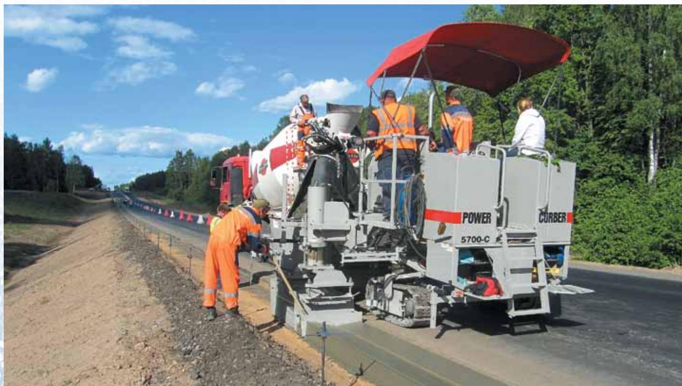
Использование бетоноукладчика Power Curbers 5700 С при устройстве прикромочных лотков
