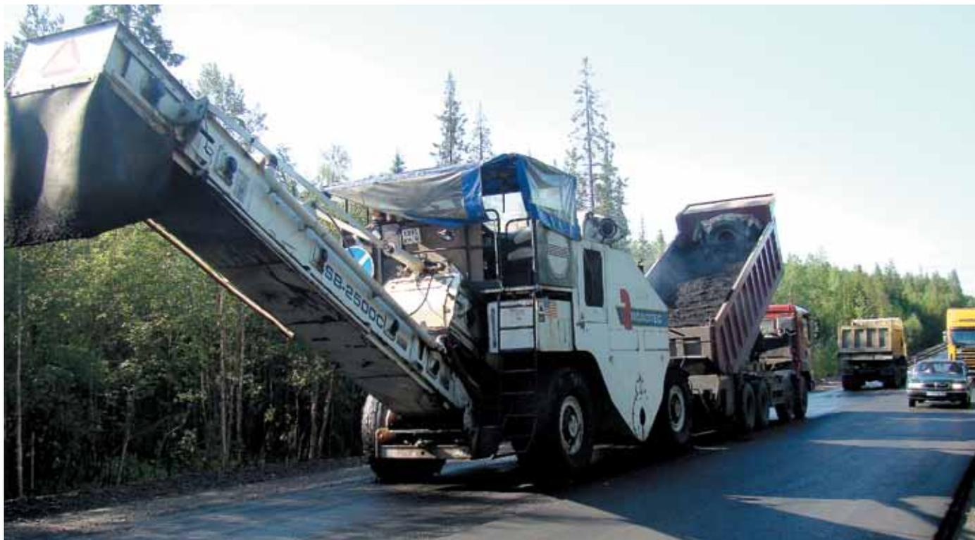
*Автомобильная дорога Р-21 «Кола». Применение перегружателя SHUTTLE BUGGY 2500B(C) при устройстве асфальтобетонного покрытия*
