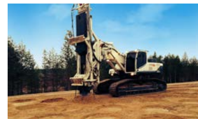
Рис. 1. Импульсное уплотнение установкой TERRA-MIX (Австрия) с шагом в шахматном порядке
