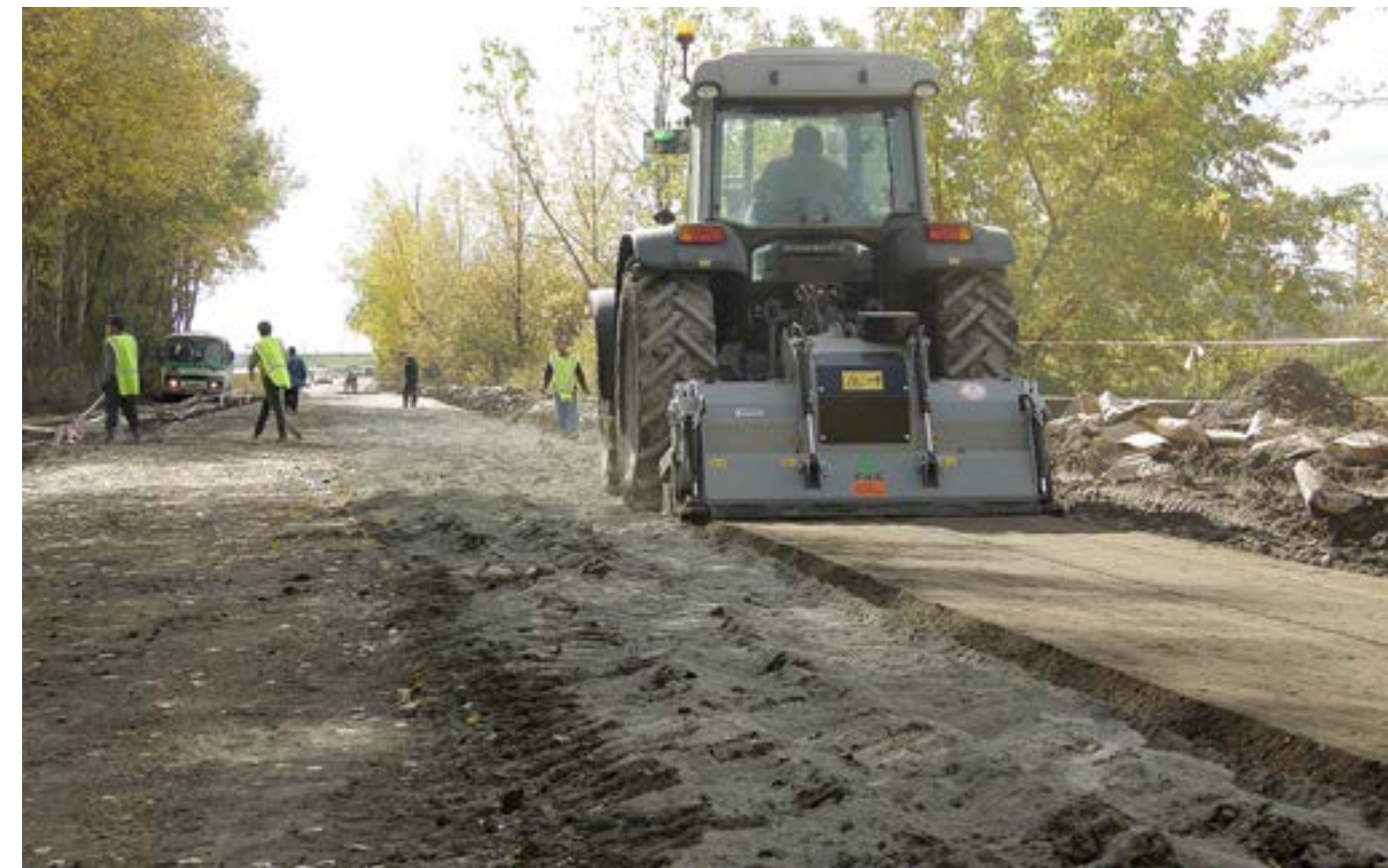
Перемешивание цемента, вяжущего и грунта
