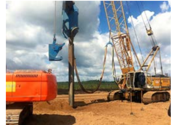
Рис. 4. Устройство песчаных свай по технологии виброзамещения
