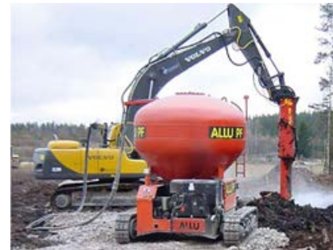
Рис. 3. Глубинное (объемное) смешивание
