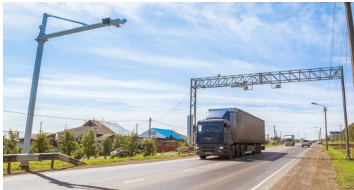
Автоматизированный пункт весового и габаритного контроля, г. Кемерово (въезд со стороны пгт Промышленная)
