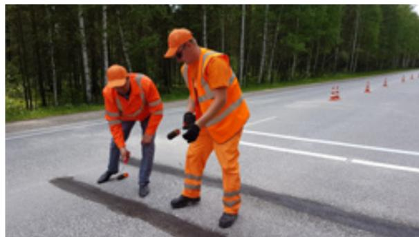
Рис. 3. Устройство подгрунтовки – праймера перед нанесением контрольных линий
