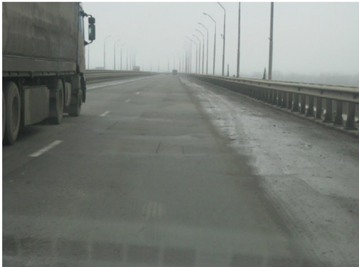
**Рис. 3. Образование неровностей на проезжей части сталебетонного моста при использовании рулонной гидроизоляции «Мостопласт»**
