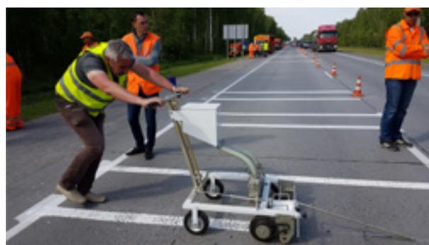
Рис. 5. Нанесение контрольных линий со структурной поверхностью
