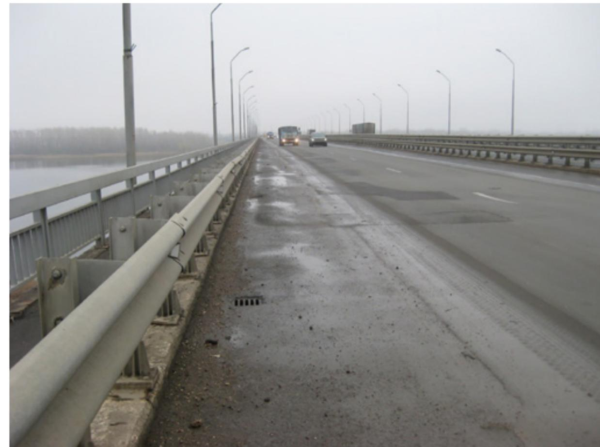
**Рис. 4. Образование вмятин и пузырей на проезжей части моста**
