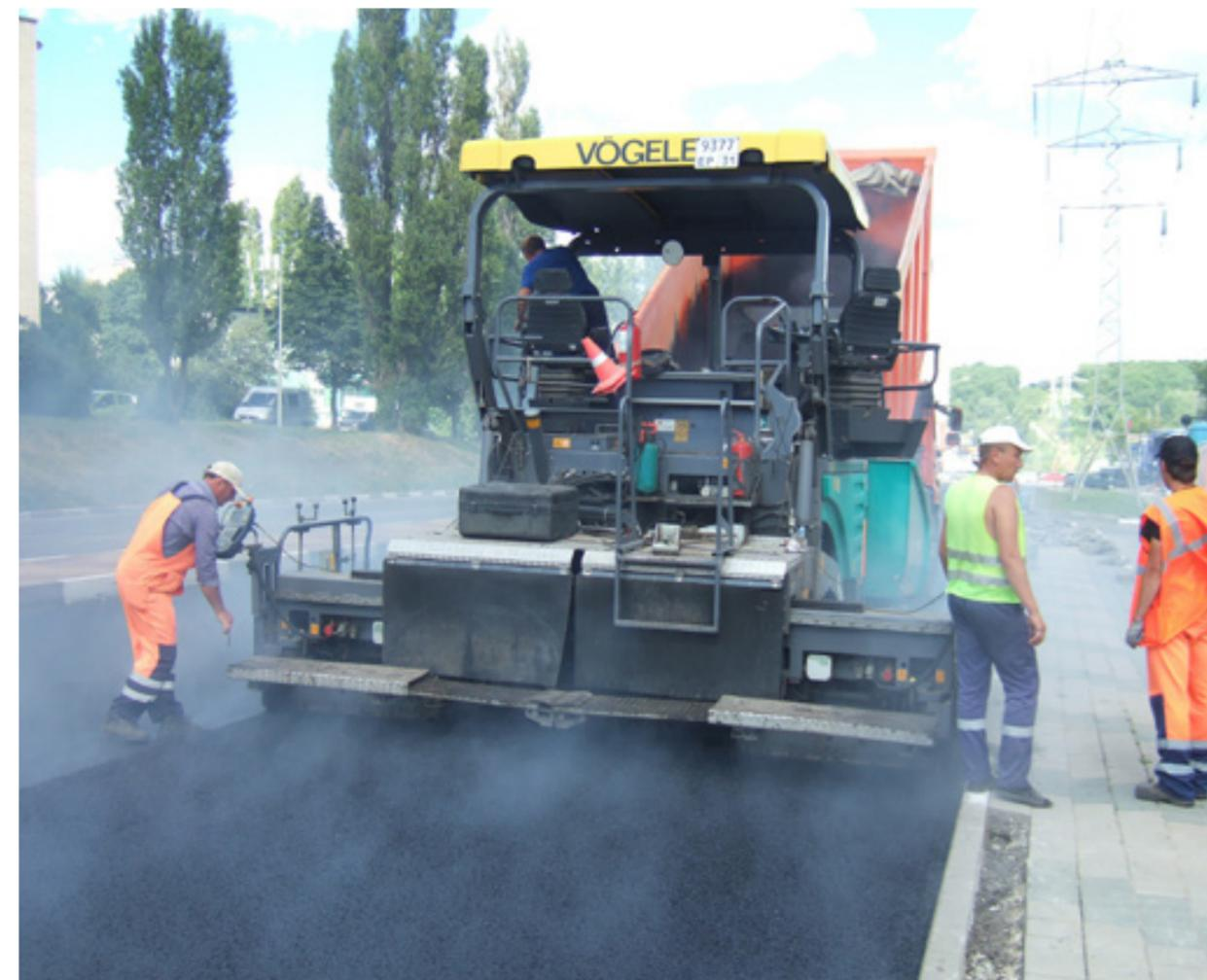
Дорожные покрытия с применением модификатора «Унирем» относятся к материалам повышенной долговечности и характеризуются высокой сдвигоустойчивостью, устойчивостью к колее- и трещинообразованию, повышенной водостойкостью, высокой ударной вязкостью при отрицательных температурах.
