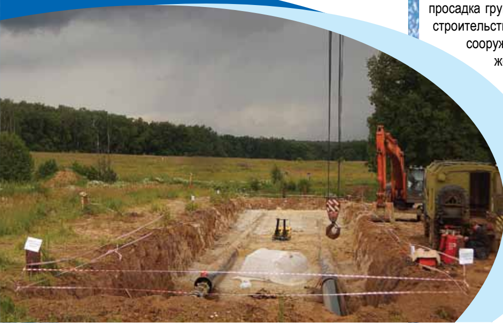
Переустройство нефтепровода
