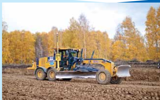
Спутниковая 3D-система при устройстве слоев дорожной одежды
