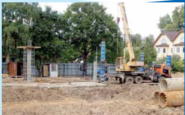
Снятие опалубки стоек лестничного схода надземного пешеходного перехода
