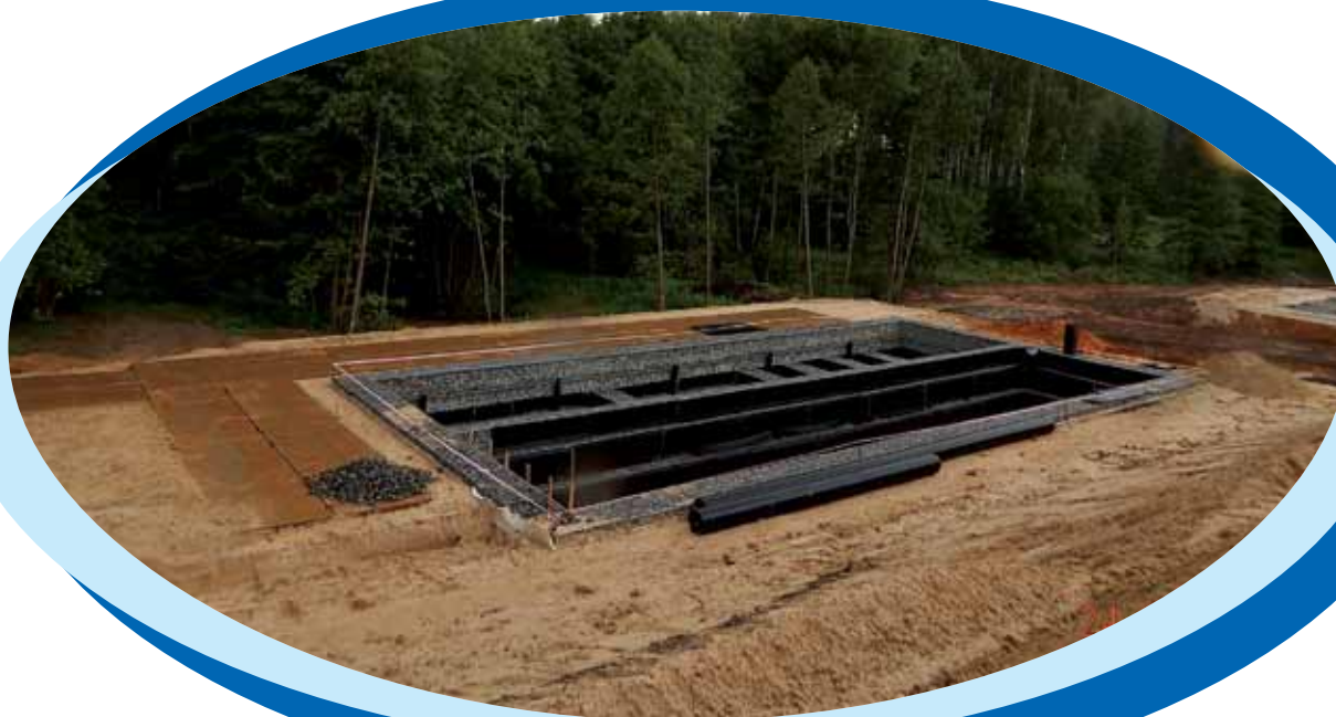
Устройство очистных сооружений
