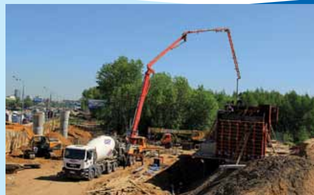
Работы по бетонированию опоры путепровода
