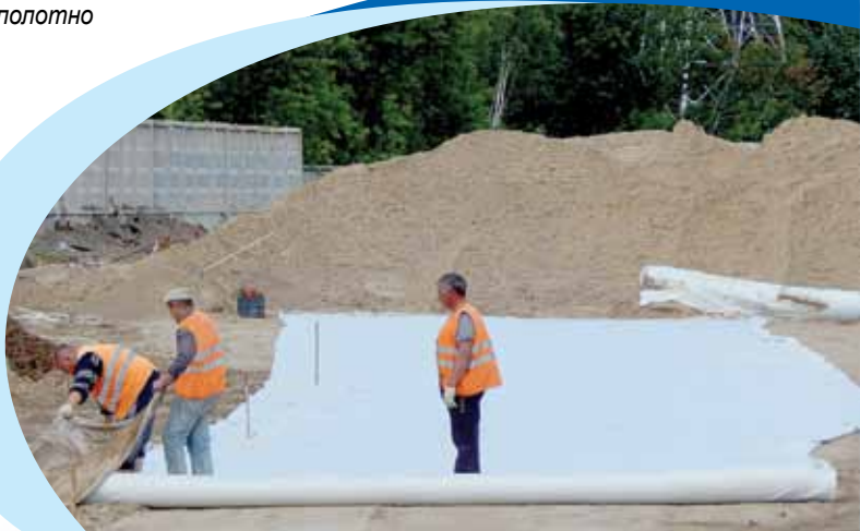
Укладка геосинтетического материала на земляное полотно
