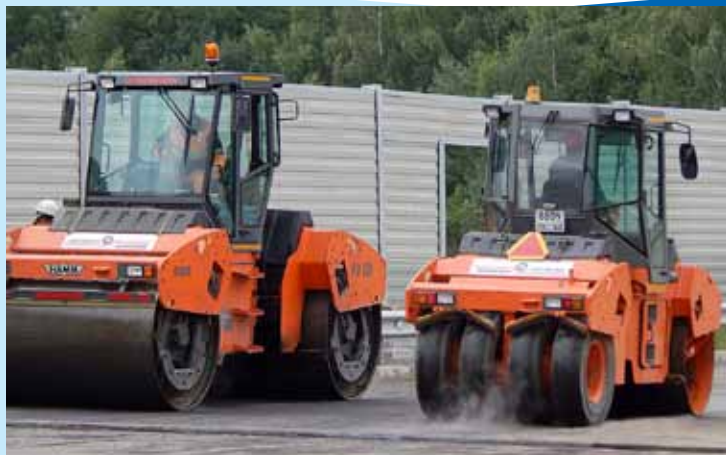
Уплотнение асфальтобетонной смеси
