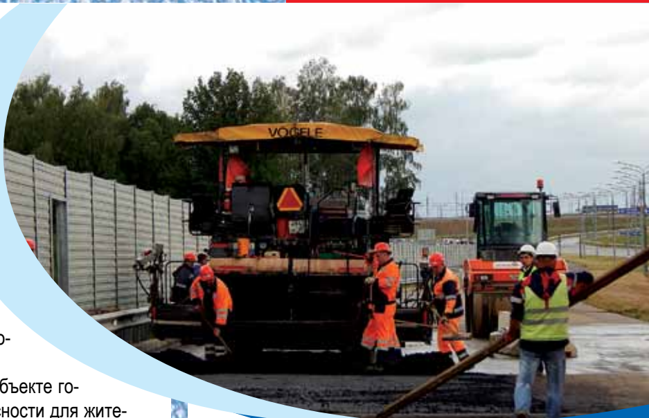
Укладка асфальтобетонной смеси
