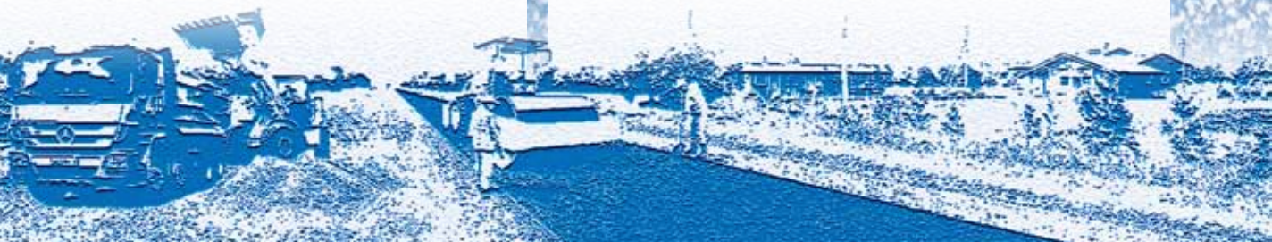
Укрепление основания насыпи земляного полотна с помощью геосинтетических материалов
