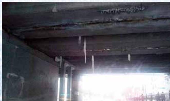
Нависающая наледь под пролетным строением на дренажных трубках
