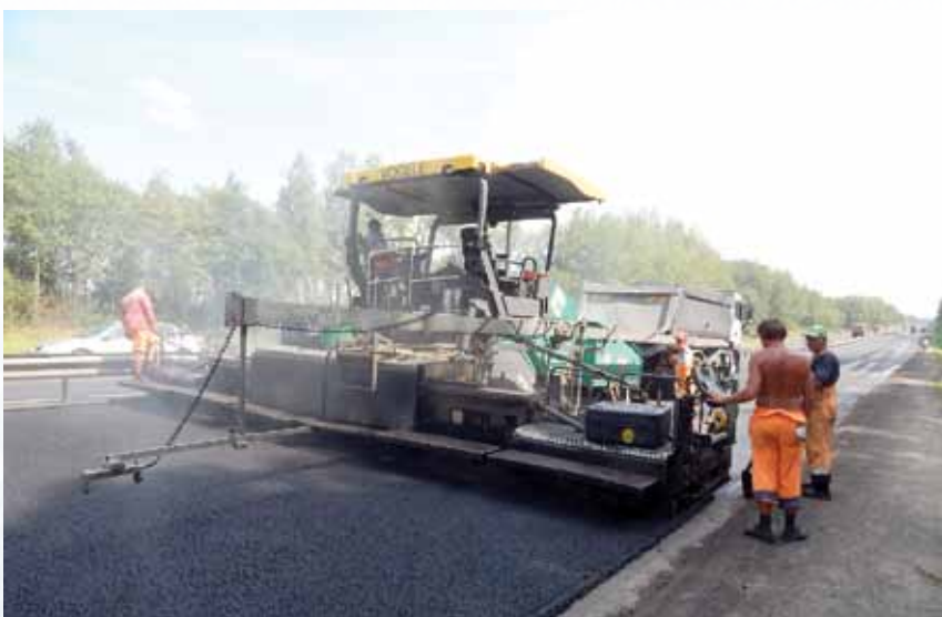
Устройство асфальтобетонного покрытия широкозахватным укладчиком
