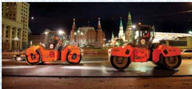
Работы по устройству асфальтобетонного покрытия на ул. Моховой, Москва
