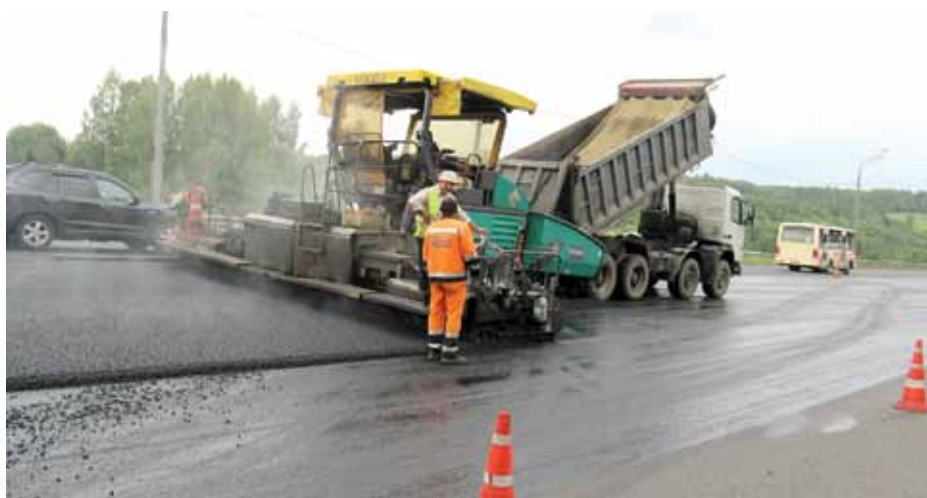
Процесс устройства асфальтобетонного покрытия
