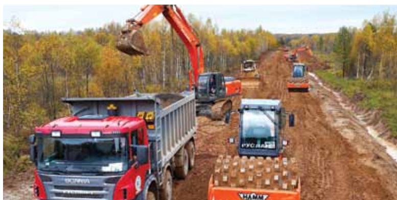
Земляные работы при строительстве автомобильной дороги
