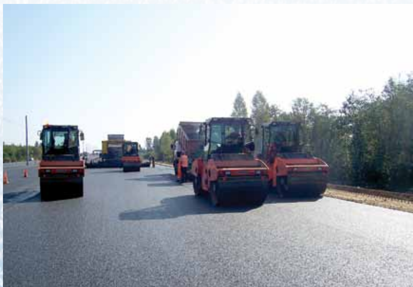
Устройство бесшовного асфальтобетонного покрытия
