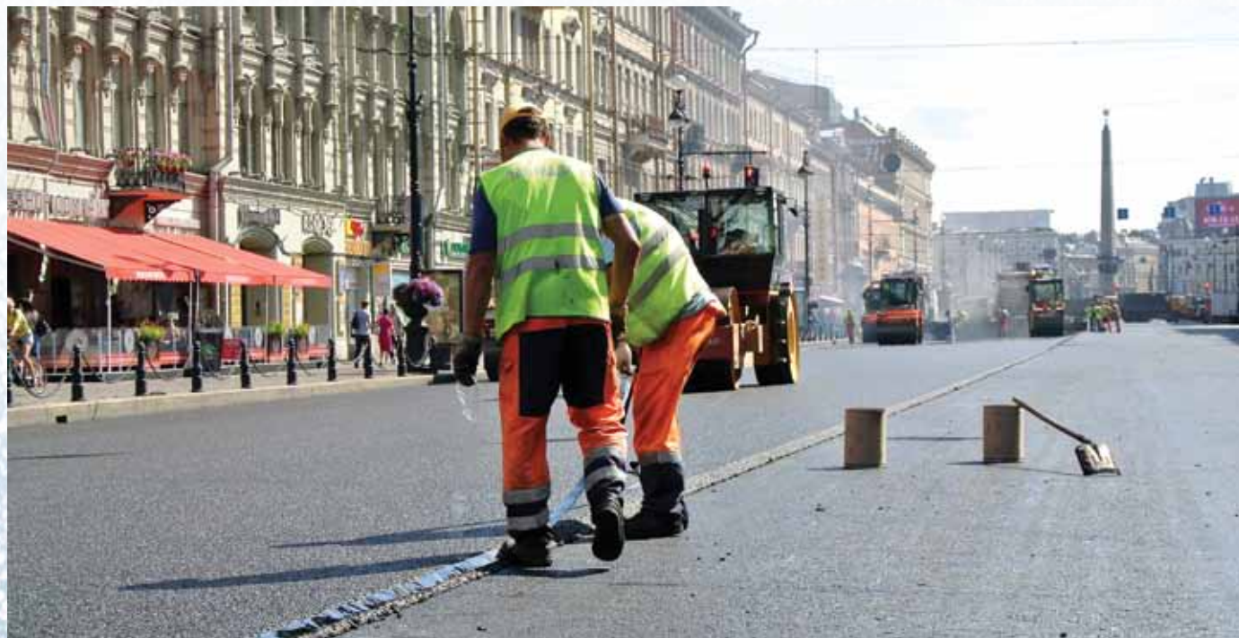
Нанесение стыковочной ленты
