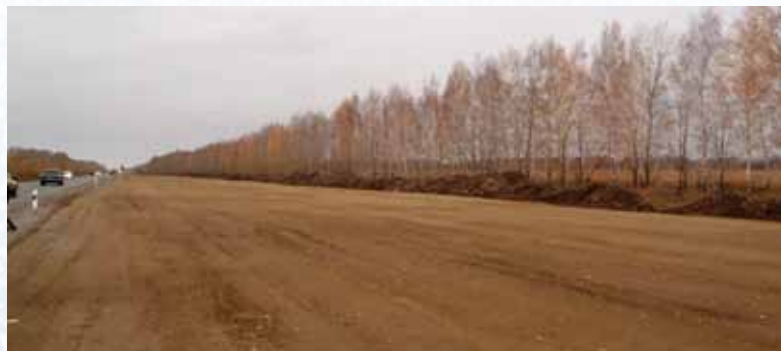
Устройство земляного полотна на реконструируемом участке
