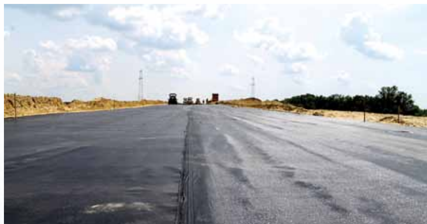
Применение геосинтетических материалов при реконструкции автомобильной дороги Белгород – Томаровка (обход Томаровки)
