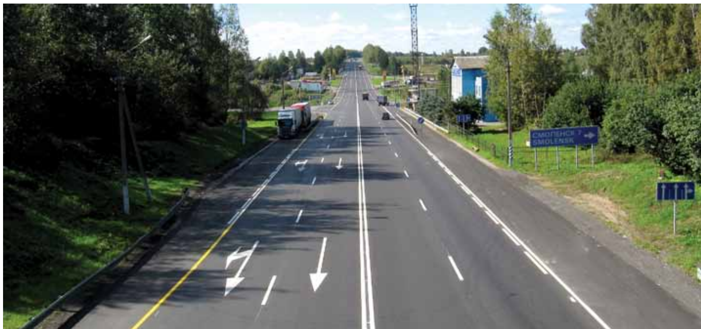
Автомобильная дорога М-1 «Беларусь» после ремонта
