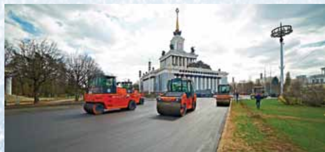
Ремонт территории ВДНХ
