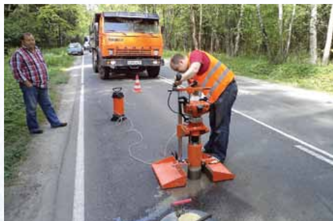
Отбор проб асфальтобетонного покрытия
