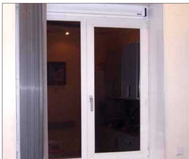
Рис. 5. Шумозащитное остекление с использованием пассивного проветривающего шумозащитного устройства
