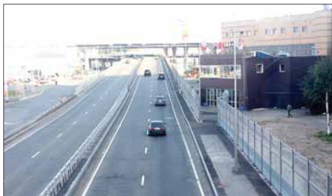
Рис. 4. Применение акустических экранов для защиты селитебной территории
