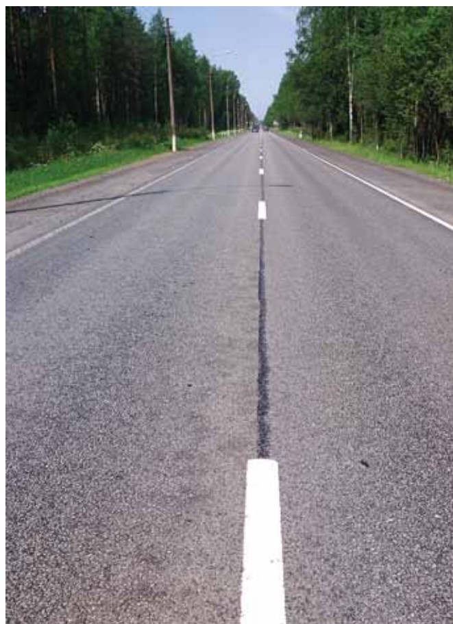
Шов на старом асфальтобетонном покрытии с использованием стыковочной ленты
