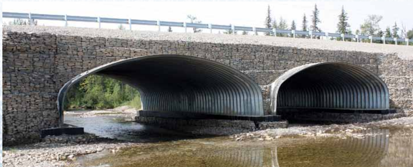
Арочный мост из металлических гофрированных материалов на автомобильной дороге А-360 «Лена»
