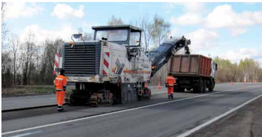
Работы по фрезерованию существующего асфальтобетонного покрытия
