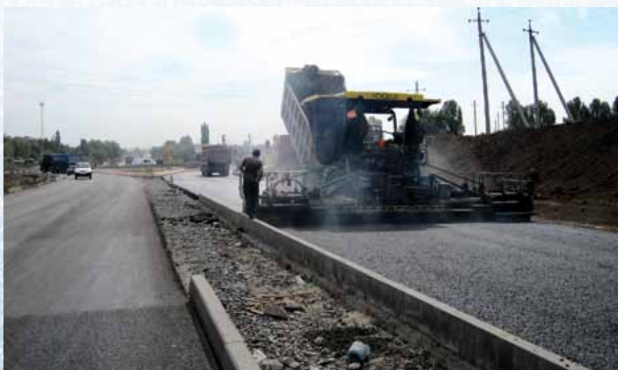
Реконструкция Юго-Западного обхода г. Старый Оскол
