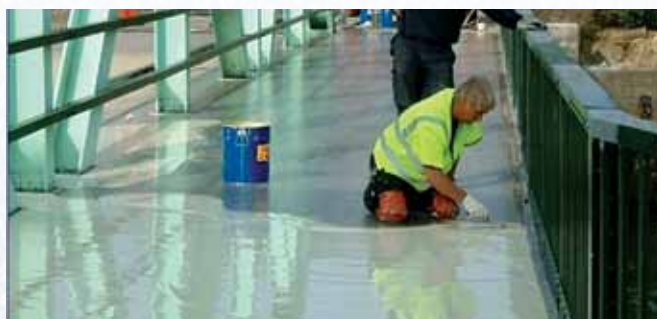
Нанесение гидроизоляционного слоя
