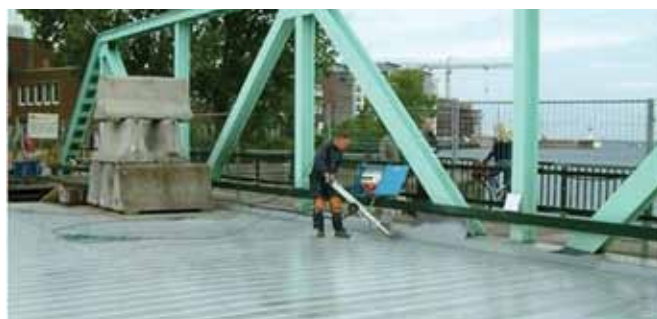
Подготовка основания, обезжиривание
