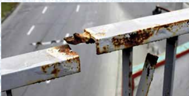
Коррозия перильного ограждения из обычной стали
