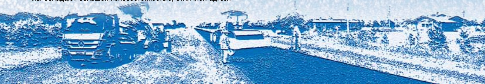
Нанесение износостойкого слоя
