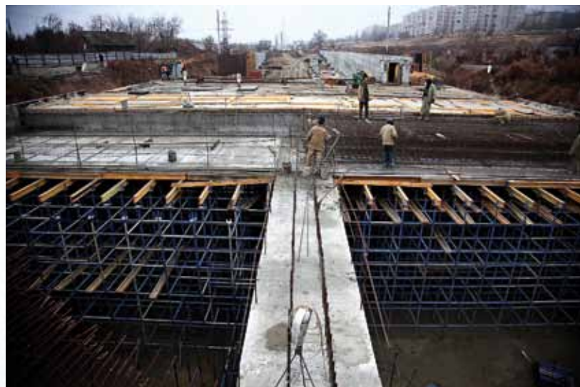
Строящийся тоннель в микрорайоне Тулака
