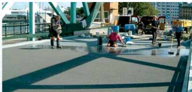
Нанесение износостойкого слоя
