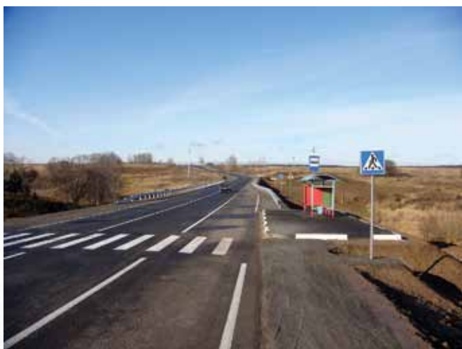
Реконструкция автомобильной дороги Тетерино – Мышкино – Поречье в Можайском районе
