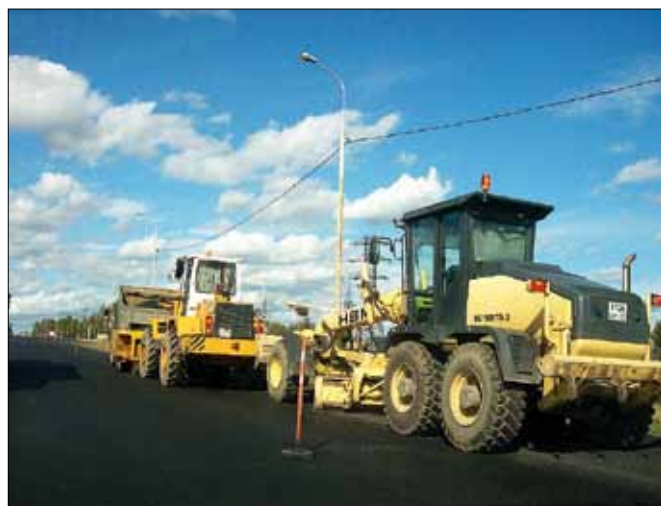
Укрепление обочин на автомобильной дороге М-3 «Украина»
