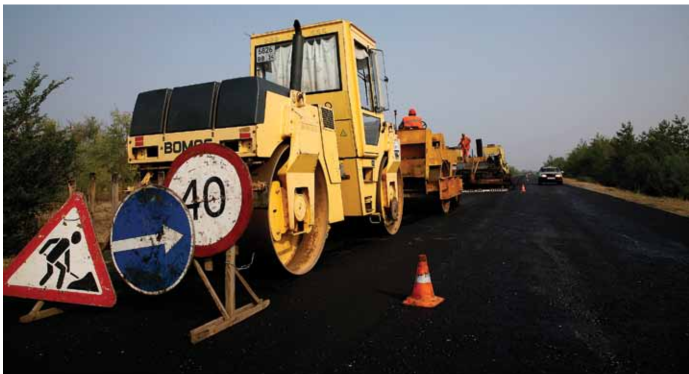
Выполнение работ по ремонту в Волгоградской области
