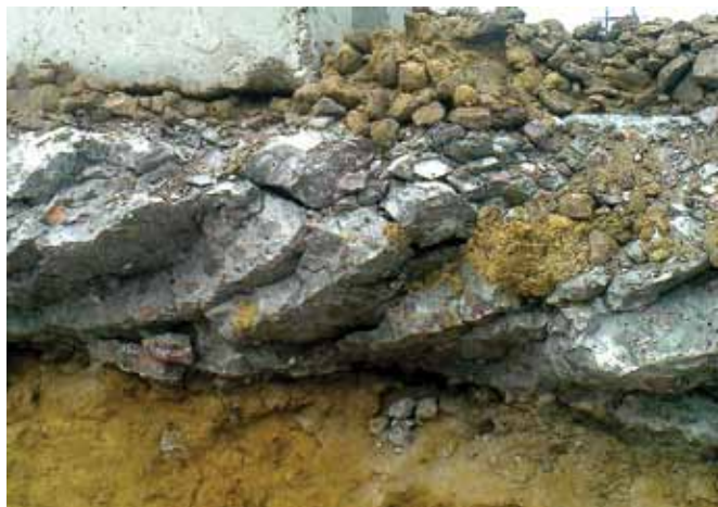
Рис. 2. Структура плиты после щебневания машиной RMI
