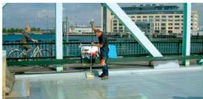
Нанесение грунтовки
