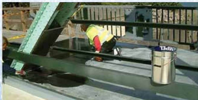
Нанесение износостойкого слоя
