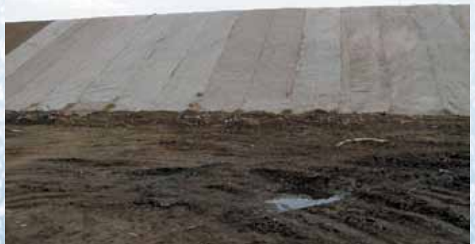
Укрепление откоса насыпи биоматами
