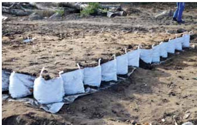
Опыт применения геоблоков. Московская область, Пушкинский район
