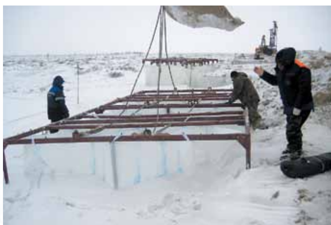
Установка геоблоков (МН «Заполярье – Пурпе»)
