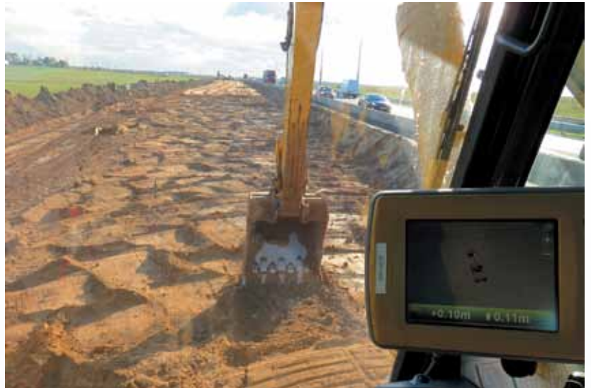
Реконструкция автомобильной дороги М-3 «Украина», км 124 – км 173. 2015 год
