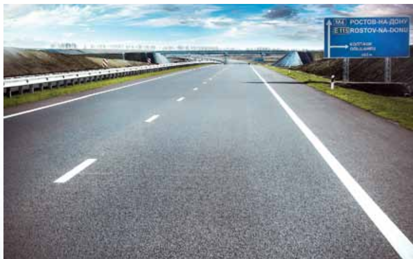
Строительство автомагистрали М-4 «Дон», км 330 – км 414,7, в Липецкой области. 2010 г.
