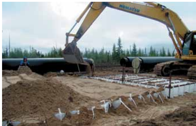
Засыпка геобоксов сыпучим грунтом (МН «Заполярье – Пурпе»)
