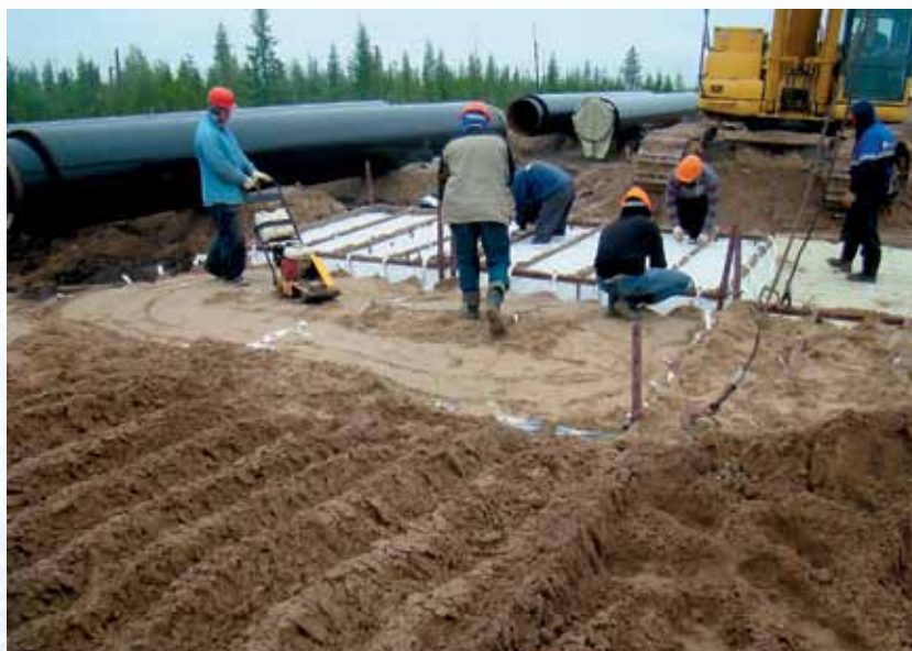
Уплотнение грунта (МН «Заполярье – Пурпе»)
