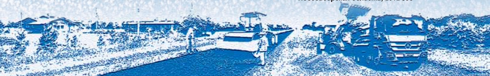
Ремонт дороги по технологии «холодный ресайклинг». Новосибирская область, 2012 год
