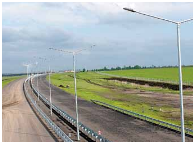
Строящийся участок М-4 «Дон» – км 517 – км 544
