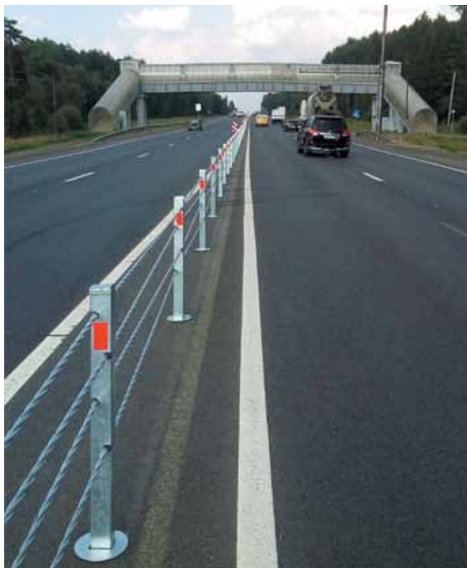
Автомобильная дорога М-1 «Беларусь», км 60 – км 61
