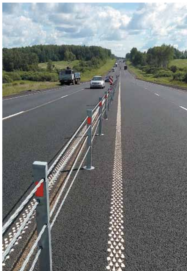
Автомобильная дорога М-1 «Беларусь», км 196. Тросовое ограждение
