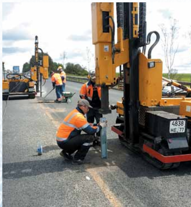
Устройство тросового дорожного ограждения на автомобильной дороге М-1 «Беларусь». Бурение отверстий и забивка гильз сваебойными машинами ORTECO HD 1000
