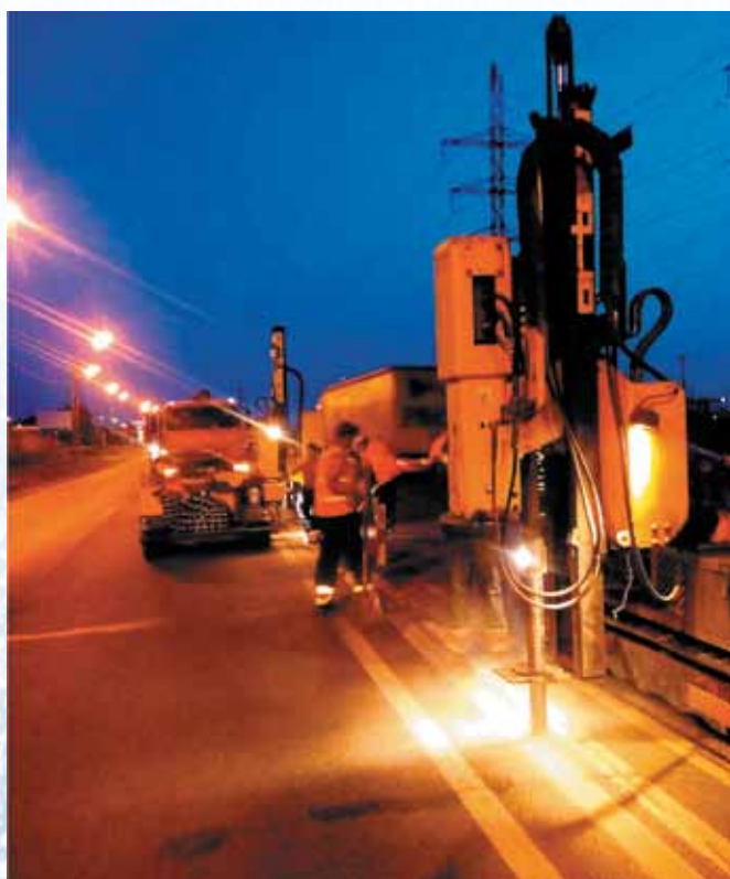
Ночные работы по установке тросового дорожного ограждения на автомобильной дороге М-8 «Холмогоры», г. Ростов
